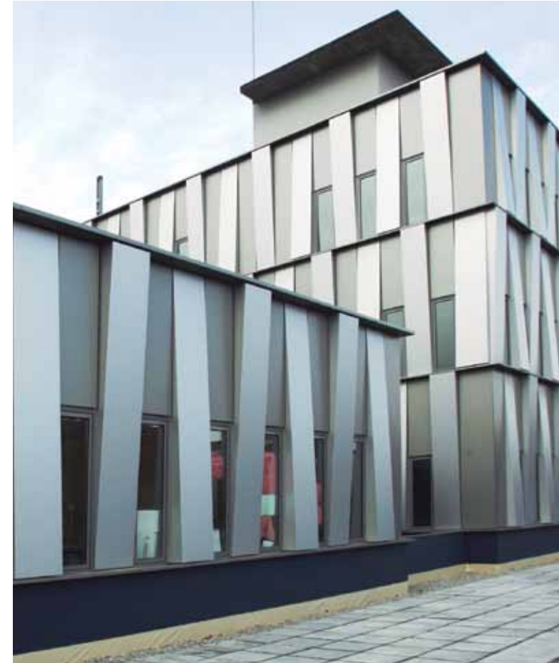
Edifici GAIA - Parc UPC. © UPC.
