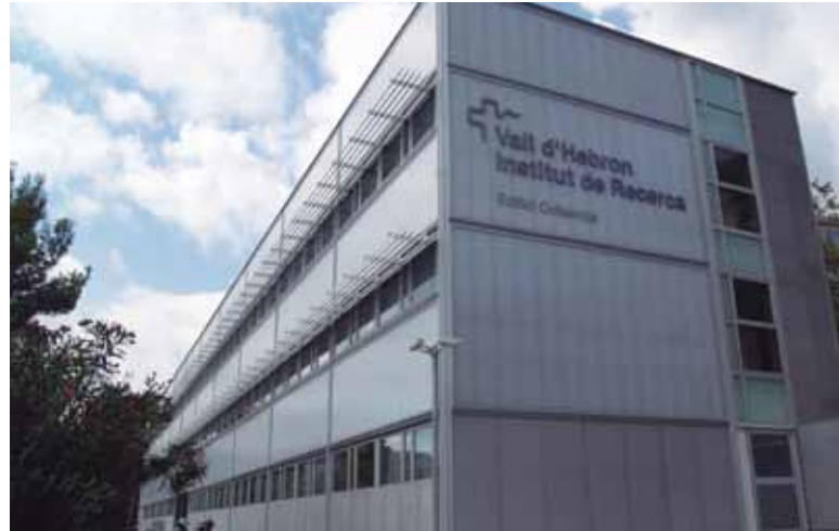
Façana de l'edifici Collserola. © VHIR.
